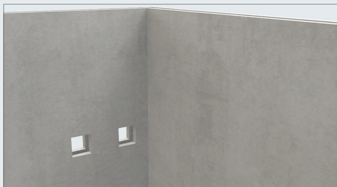
Рис. 42. Під час улаштування стін передбачити відповідні отвори для подальшого монтажу стрижневих елементів.
