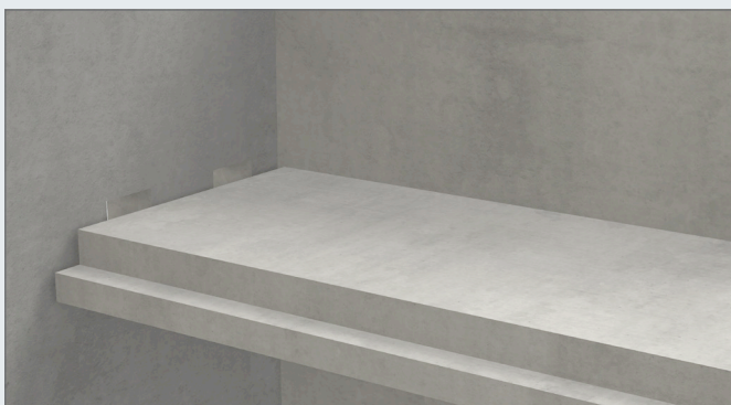
Рис. 43. Підймання збірного майданчика в проєктне положення та вирівнювання за рівнем отворів.
