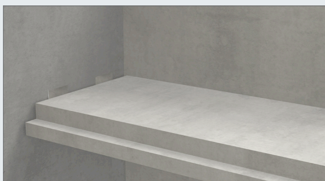
Рис. 47. Підймання збірного майданчика в проектне положення та вирівнювання за рівнем отворів.
